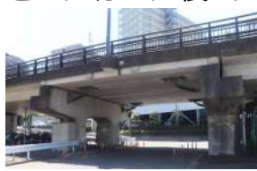
後田橋橋脚下
