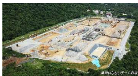
石垣島のミサイル基地建設中
