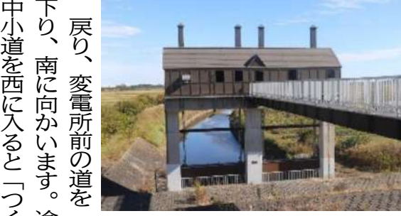
金谷排水堤樋管
