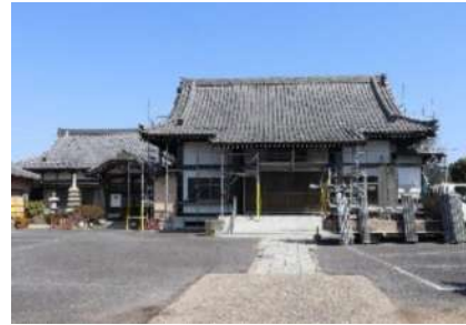
最勝院・改修中
