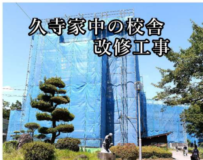
工事中の久寺家中学校校舎
